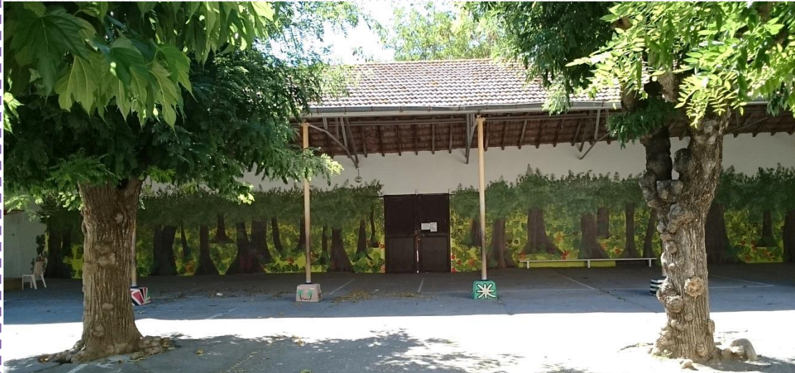
Fresque murale réalisée par l'école Lou Malhoulet après la réhabilitation du mur par le service technique municipal – Mai 2018.
